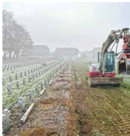
Die Entfernung der alten Hecke ist abgeschlossen.
