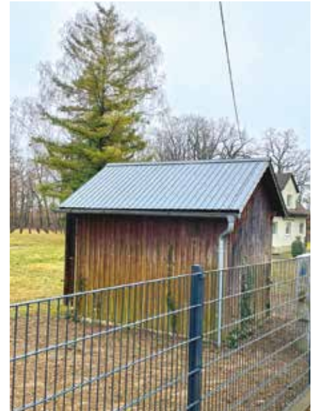
Die sanierte Gerätehütte am Soldatenfriedhof Marchtrenk hinter dem neu errichteten Doppelstabmattenzaun
