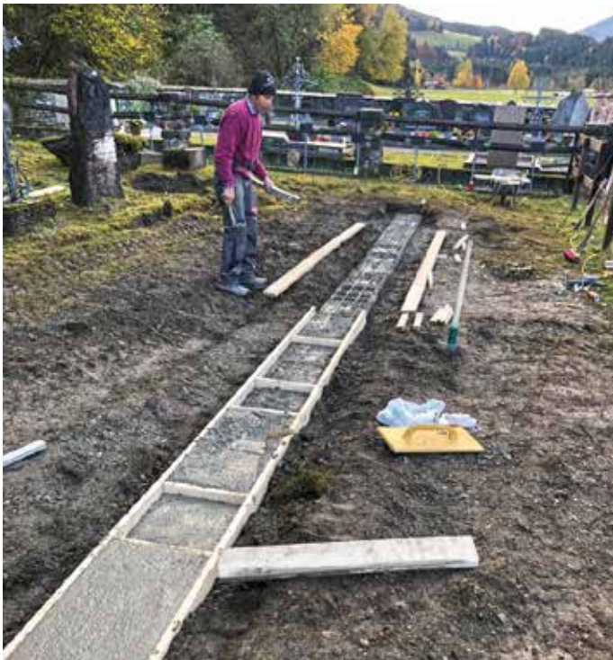
Arbeiten zum Anlegen des Streifenfundaments
