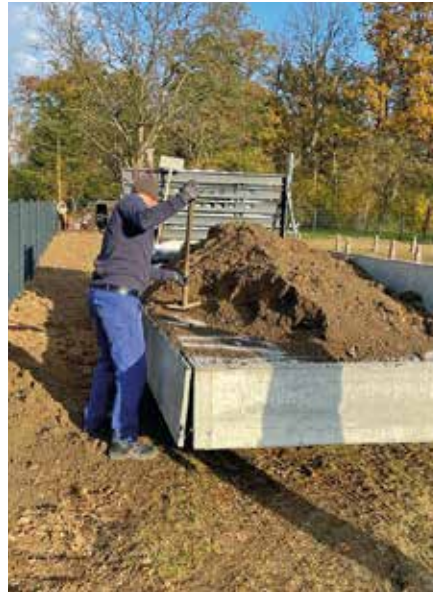
Ein Mitarbeiter der Firma Reci Zaun aus Marchtrenk bei der Arbeit
